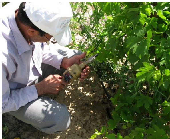
شکل ۲- نصب کنتور جهت اندازه‌گیری آب آبیاری
