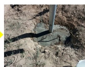
۴- سیمان کردن اطراف ستون
